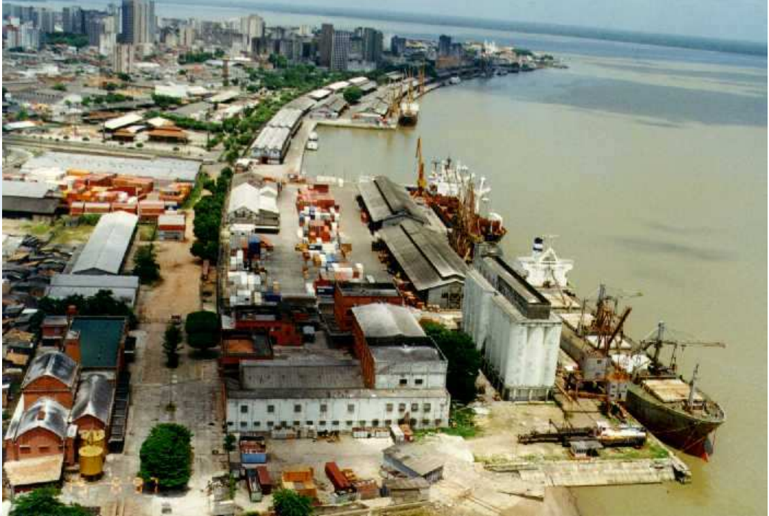
Figura 15 - Vista aerea do Porto de Belém - PA
